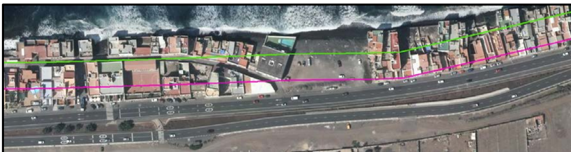
FIGURA 3. TRAMO DE FRANJA COSTERA CON PROPIEDADES PRIVADAS OCUPANDO EL DPMT. FUENTE: IDECANARIA
